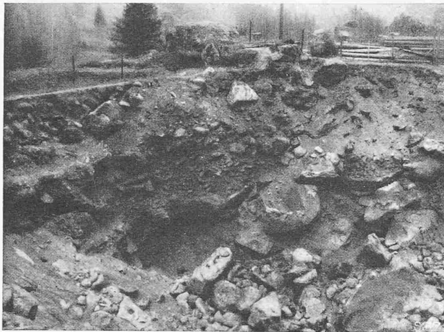
Abb. 1. Tagbruch-Trichter über dem Umlauf-Tunnel
