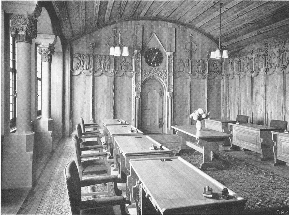
Abb. 16. Der Regierungsratsaal; Decke und Säulenkapitelle vom Altbau
