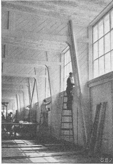
Abb. 5. Die Halle im Ausbau
