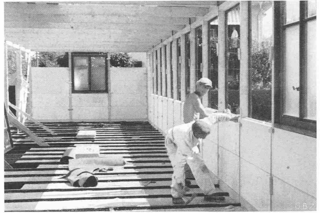
Abb. 10. Durisol-Blindboden. Einsetzen der Platten und Fenster
