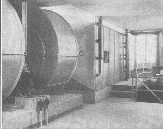
Konditionierungsaggregat zur Klimaanlage
