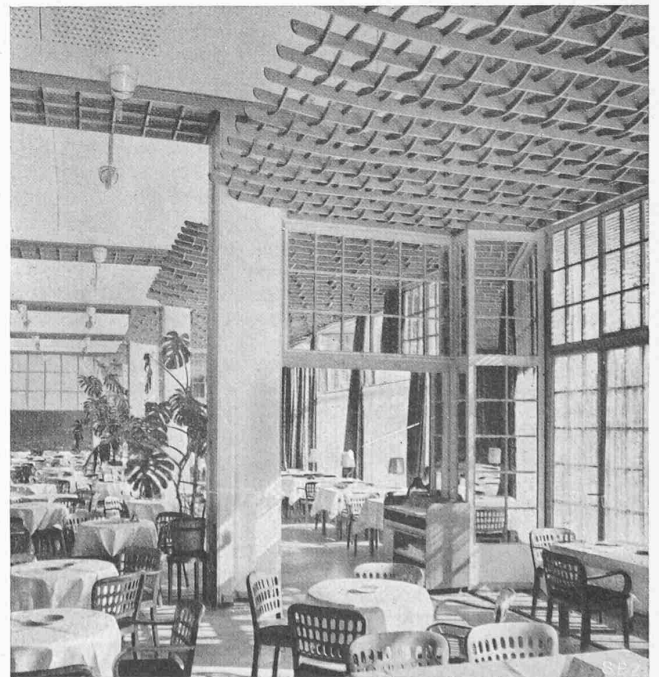
Abb. 38. Gartensaal. Seeseitige Längswand mit den, die Höhe und den Gliederungsmaßstab reduzierenden Holzgittern. Bildung leichter Nischen durch verspiegelte, gegitterte Querwänden
