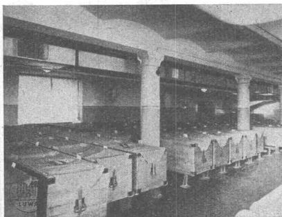
Klimatisierter Tabaklagerraum in einer Zigarettenfabrik
