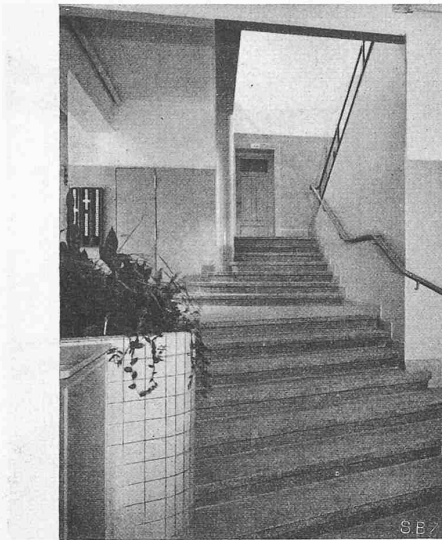
Abb. 7. Treppenhaus im Werkstattbau vergl. untenstehenden Grundriss
