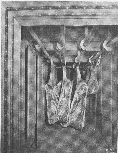
Abb. 4. Schnellgefrier-Tiefkühlschleuse
