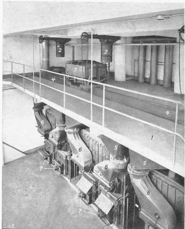
Abb. 29. Taschenkessel von Gebr. Sulzer. 1 Bedienungspodest, 2 Siloausläufe, 3 Rollwagen mit Waage, 4 Einfüllöffnungen der Tagesbunker 5, 6 Schwenkarme, 7 Unterwindgebläse
