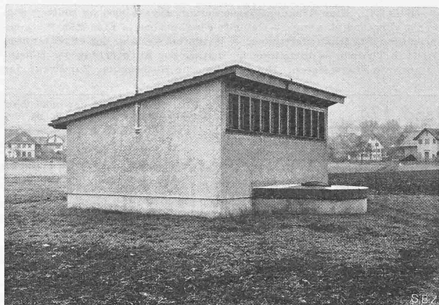
Abb. 3. Pumpengebäude mit angebautem Sammelbrunnen
