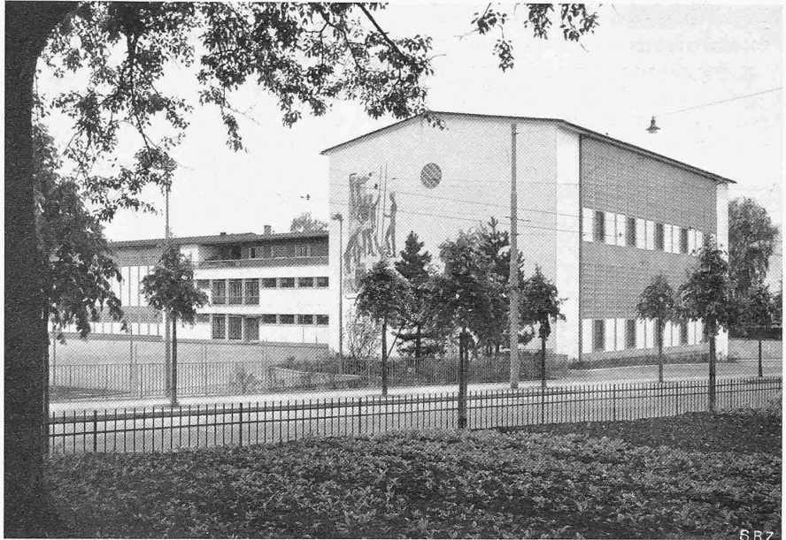
Abb. 3. Ansicht aus Norden, von der Gloriastrasse aus
