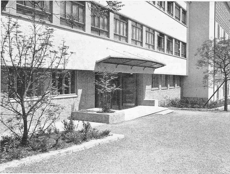
Abb. 2. Ansicht der Haupteingangs-Partie an der Rämistrasse
