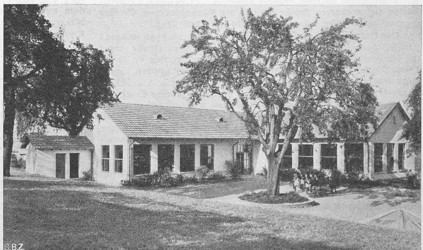
Abb. 14. Gesamtbild des Kindergartens aus Süden
