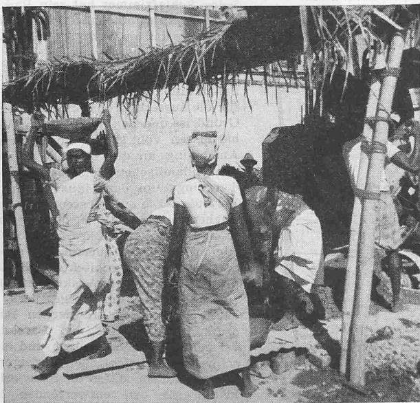
Abb. 4. Frauen beim Betontransport
