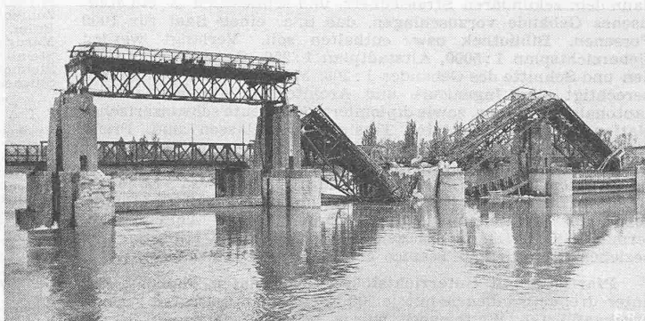
Abb. 3. Stauwehr Kembs vom Oberwasser aus, Oeffnung 2 (am wenigsten beschädigt), Oeffnung 3, 4 u. 5. Aufbau Pfeiler III und Widerlager rechts durch Sprengung zerstört. Windwerks- und Strassenbrücke eingestürzt, Oeffnung 5 oberwasserseitige Dammbalken eingesetzt. Unterwasserseitig Kriegsnotbrücke
