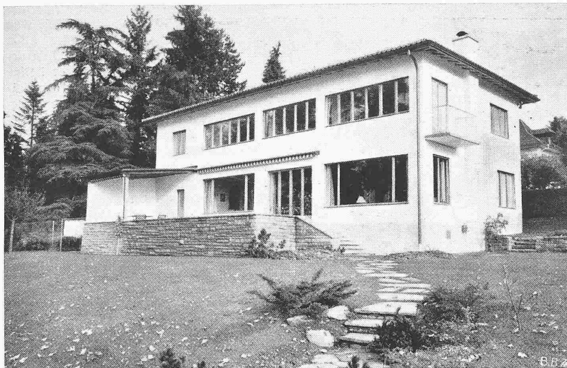
Abb. 4. Ansicht von Südosten
