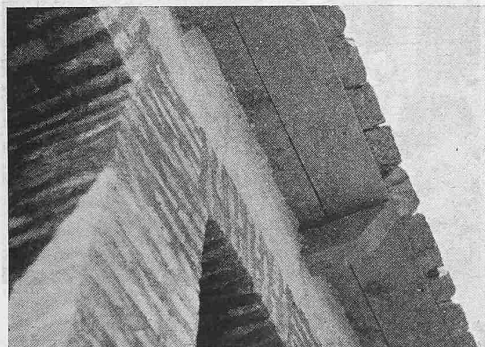
Abb. 12. Kleine Soldatenmoschee (Baubureau Armeekorps Kabul). Lehmdach mit Traufkante aus Steinplatten
