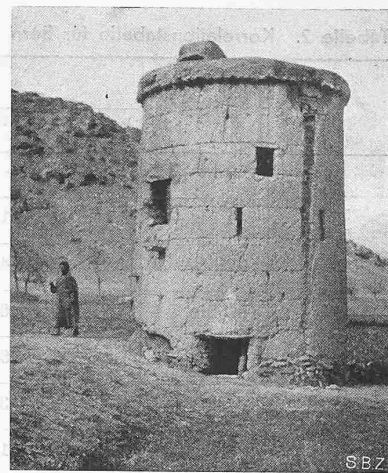
Abb. 3. Wachturm eines Ackerfeldes in Afghanistan; gestampfter Lehm. Zerstörung von unten setzt ein, wo der Feldsteinssockel zu niedrig ist; von oben, wo der Steinplattenkranz eine defekte Stelle aufweist
