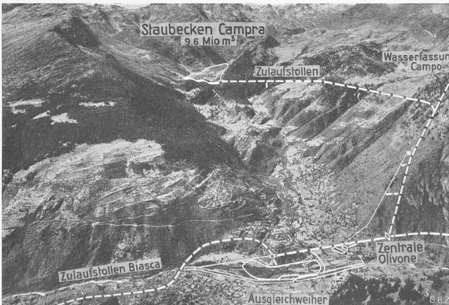
Bild 14. Olivone mit Blick gegen den Lukmanierpass, gesehen von Ost nach West
