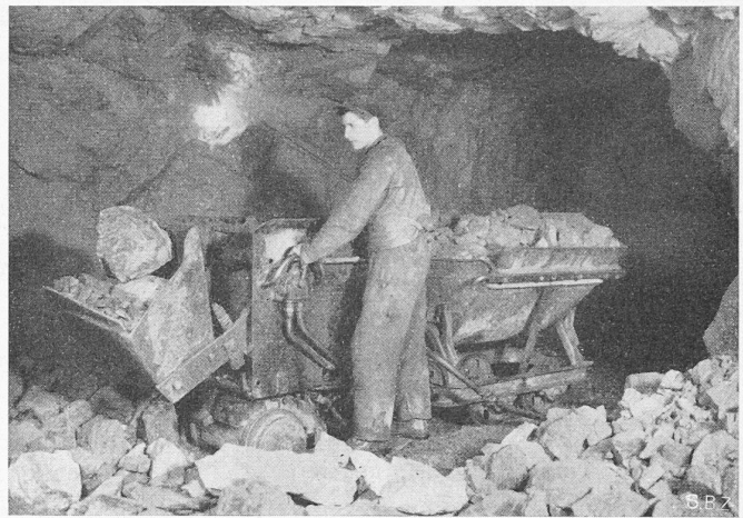
Bild 12. Lademaschine «Atlas-Diesel» mit Schaufel für 1/8 m³
