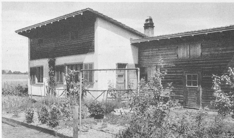
Bild 1. Siedlung Hegmatten, Haus mit Schopf aus Südosten
