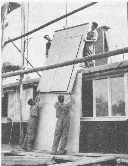
Bild 2. Innenwandelemente für das Obergeschoss
