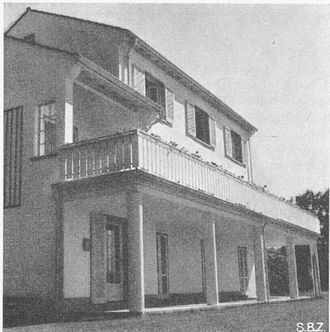
Bild 1. Südlicher Flügel aus Südwest
