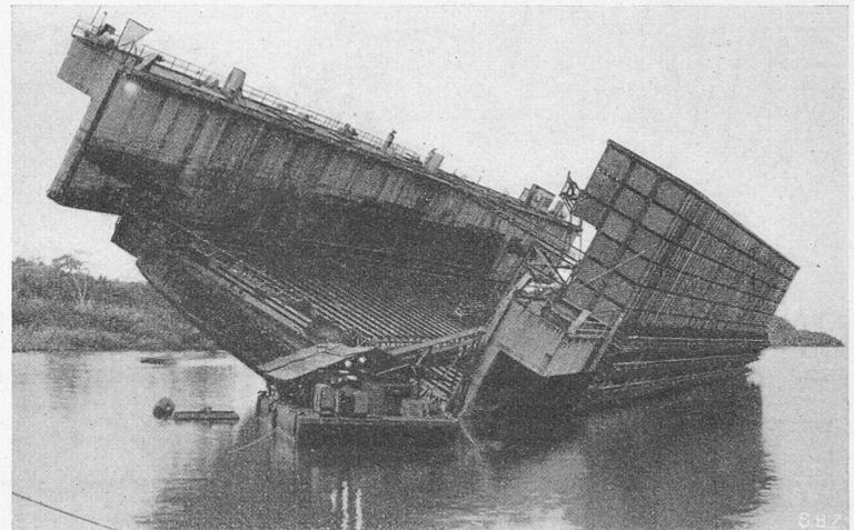
Bild 5. Das Dock wird in Hochkant-Stellung gebracht
