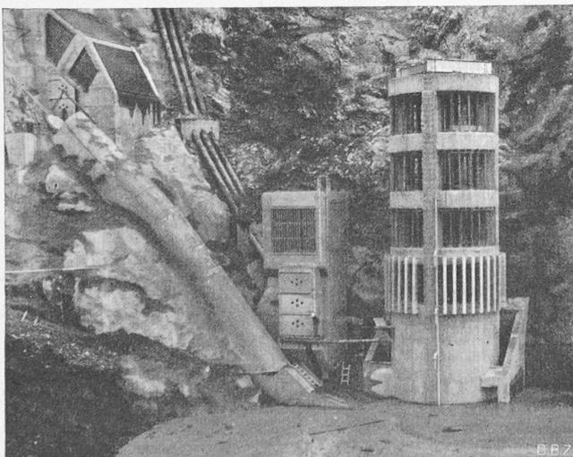
Bild 10. Neuer Grobrechenturm, ausgeführt im Jahr 1939
