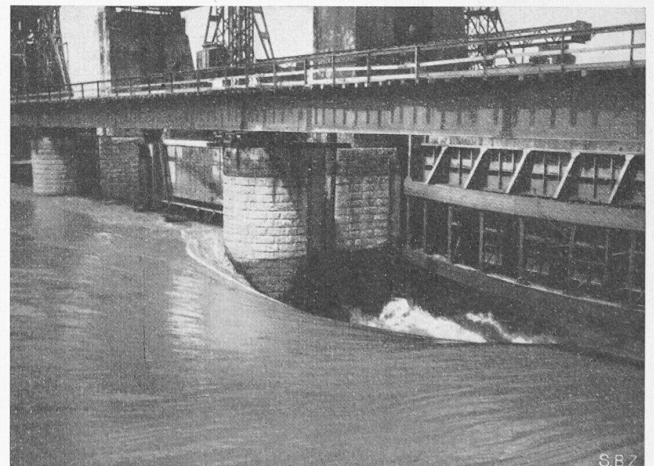
Bild 14. Einströmen von 1100 m 3 /s Wasser in Öffnung 5 am 14. Juni 1946; starke Kontraktion bei Pfeiler IV infolge Querströmung längs der geschlossenen Schütze 4. Das Bild zeigt die wieder instand gestellte untere Schütze 5
