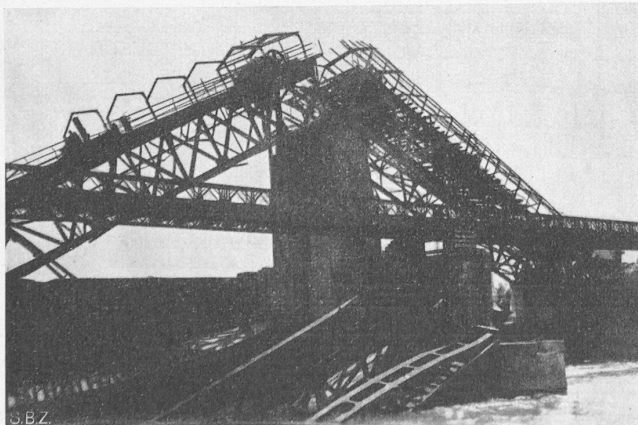
Bild 1. Oeffnung 5, am deutschen Ufer, von Unterwasser. Dammbalken, Strassenbrücke, Schützen, Windwerksbrücke sind zerstört. Bailey-Brücke an Stelle der gesprengten Strassenbrücke
