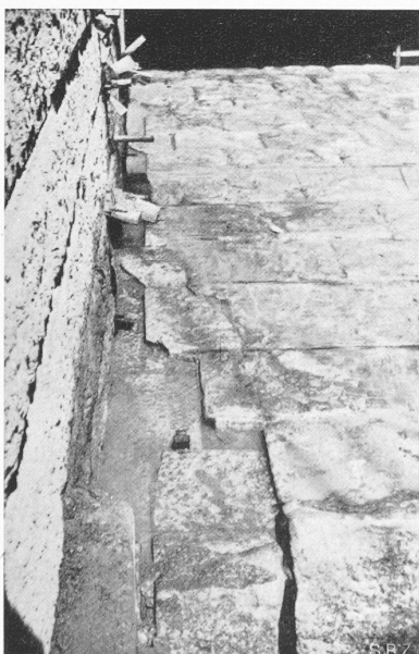
Bild 26. Schubriss in der Wehrschwelle längs linkem Widerlager. Die Querfuge im Vordergrund zeigt das Mass der Längsverschiebung
