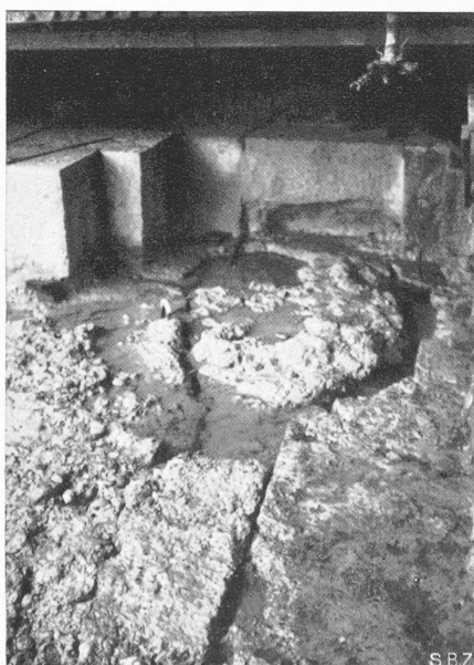
Bild 27. Fuge zwischen Widerlagercaisson (rechts) und Schwellenplatte (links), dahinter Beton des Fugenschlusses zwischen oberem Schwellencaisson und Widerlagercaisson und neu verlegte Granitquader unter Dammbalken
