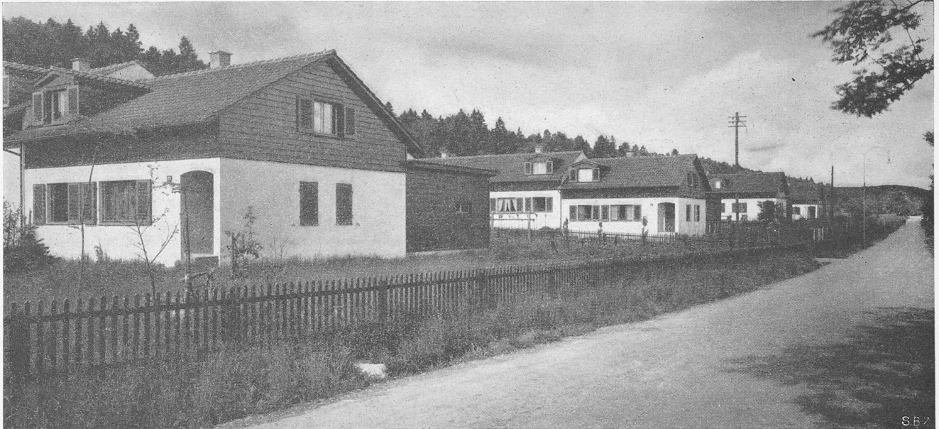
Bild 1. Stadtrandsiedlung in Zürich-Neuaffoltern, aus Osten. Arch. ALBERT JENNY, Zürich
