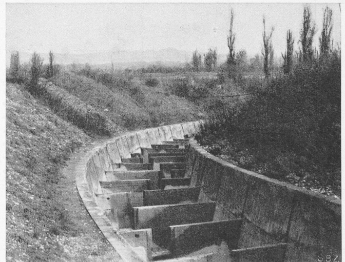
Bild 2. Blick in den neuen Fischpass des Stauwehrs Kembs
