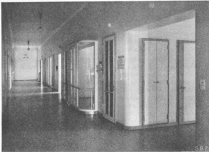
Bild 12. Bettentrakt-Korridor; rechts Gang zur Gebär-Abteilung
