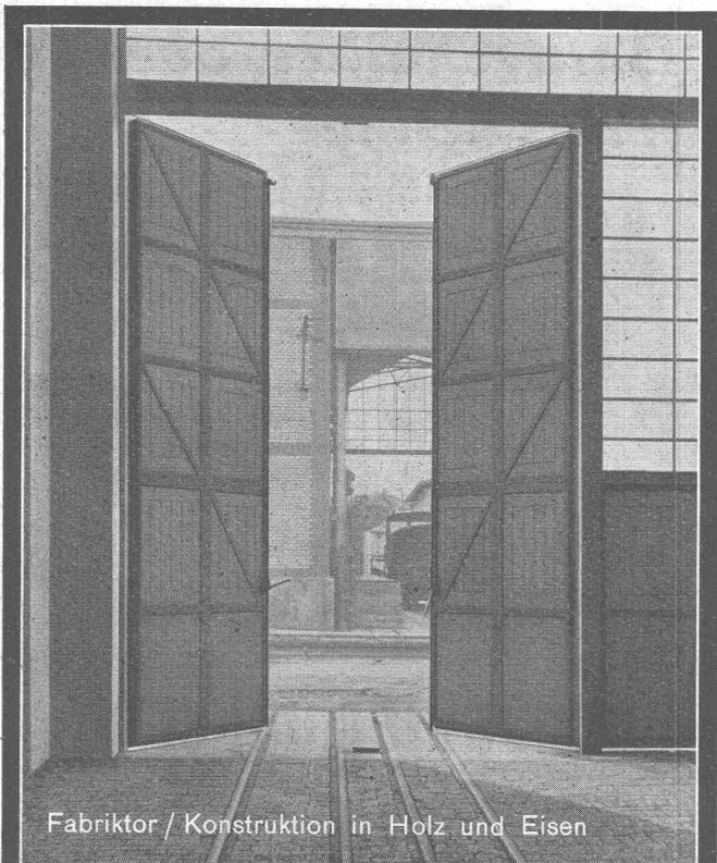
Fabrikator / Konstruktion in Holz und Eisen
