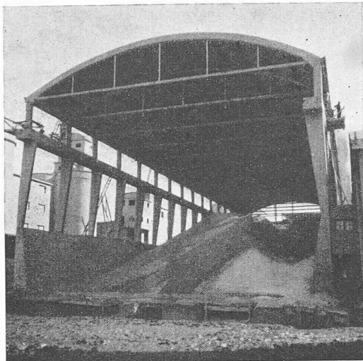
Bild 1. Klinkerhalle von Westen
