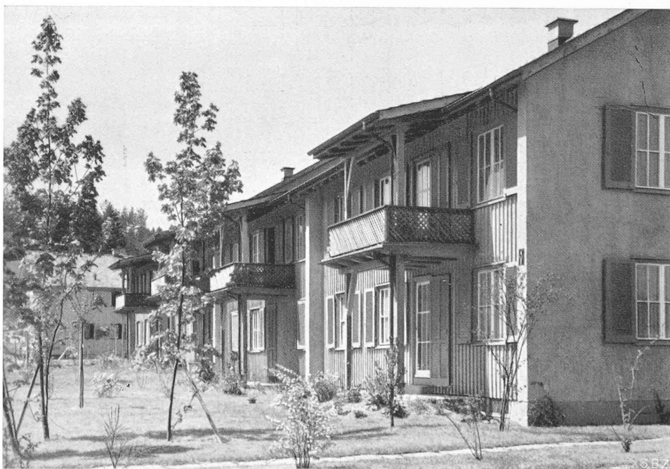
Bild 5. Einzelheiten der Holzbauweise (Stirnwände und Brandmauern massiv)
