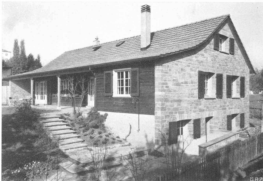
Bild 3. Haus B. in Binningen, Südoststecke. Arch. E. EGELER, Basel
