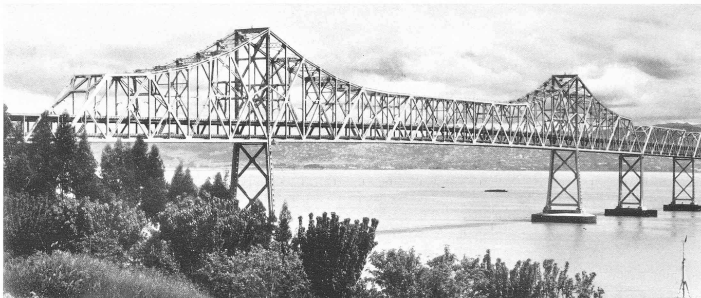
Bild 21. Ausleger-Brücke über die Bucht von San Francisco
