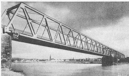
Bild 10. Rheinbrücke bei Neuwied
