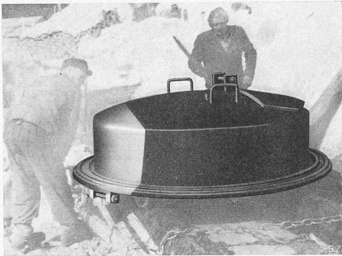
Bild 7. Als Schwimmkörper ausgebildeter Abschlussdeckel
