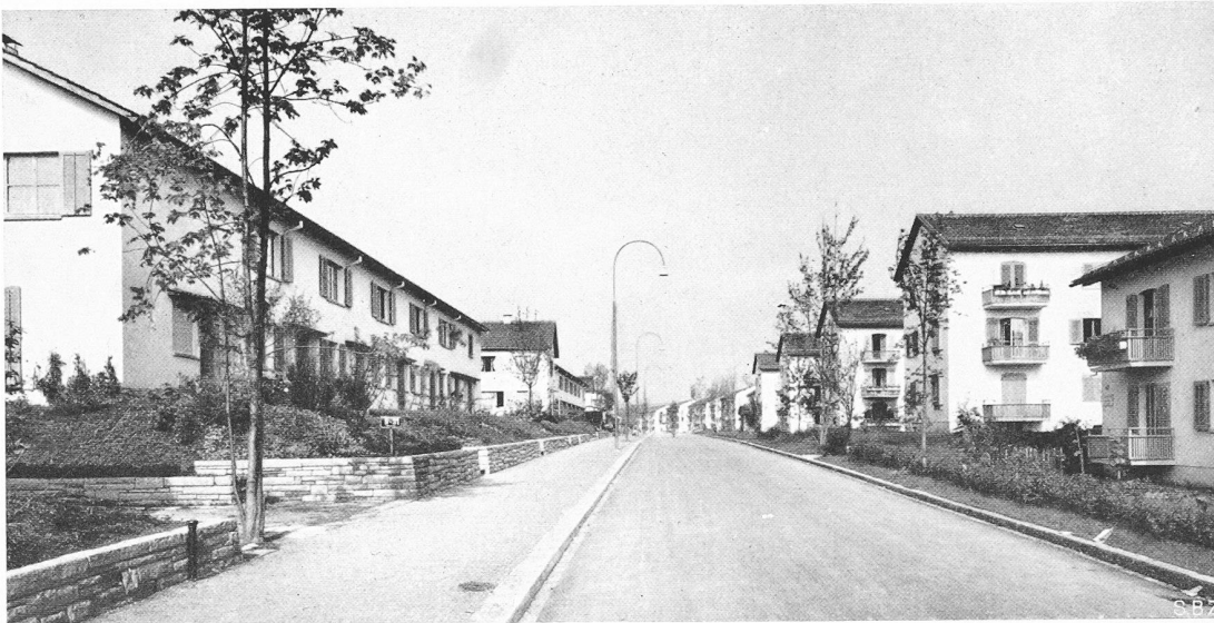
Bauobjekt: Ein- und Mehrfamilien- haus-Siedlung Katzenbachstrasse
