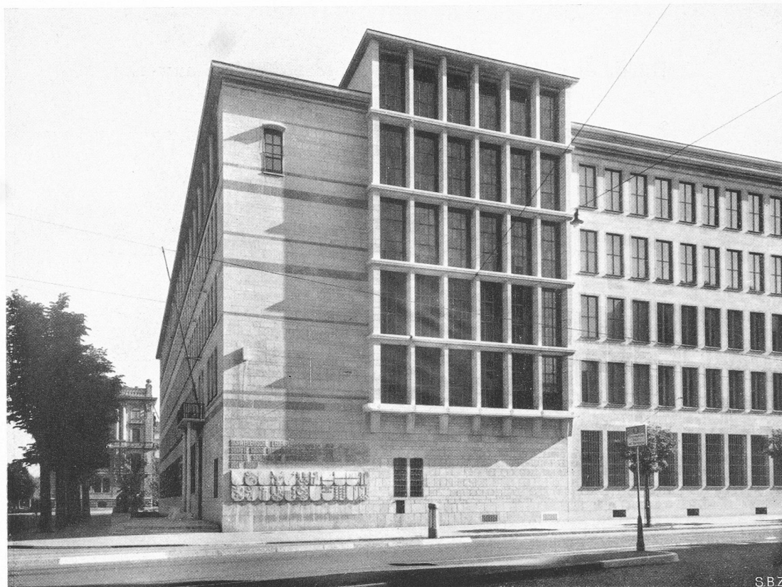
Bauobjekt: Geschäftshaus Rentenanstalt, Alpenquai 40 Bauherr: Schweizerische Lebensversicherungs- und Rentenanstalt Architekten: GEBRÜDER PFISTER, Zürich
