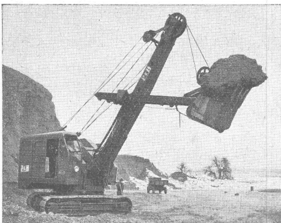
Löffelbagger mit Tru-Lay-Brugg-Drahtseilen ausgerüstet
