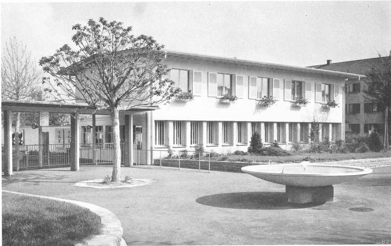
Haupteingang am Letzigraben mit Dienstgebäude
