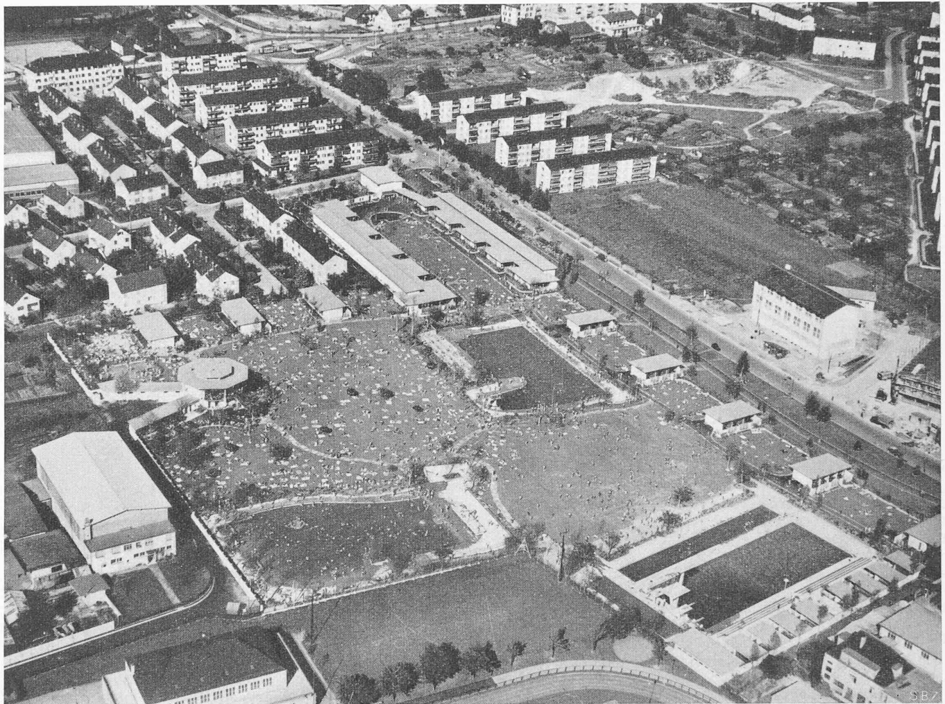
Bild 1. Gesamtanlage aus Südwesten. Zur Orientierung: im Hintergrund die Tramhaltestelle Letzigraben in der Badenerstrasse
