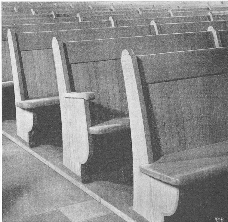
Bild 7. Detail-Ausschnitt Kirchenbänke. Boden Quarzit, eichener Randfries, Douglas-Boden unter den Bänken, diese aus massivem Tannenholz, elektrische Fusschemelheizung
