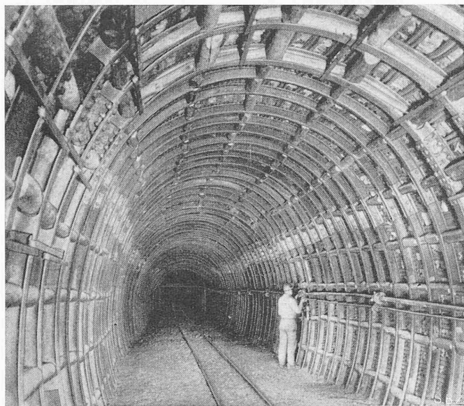
Bild 18. GHH-Strecken-Ellipse, Stein V Auguste-Victoria
