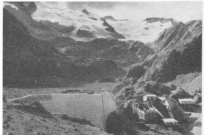
Bild 2. Kraftwerk Handeck II, Staumauer Mattental (Urbachtal) aus Fro-Be-Beton
