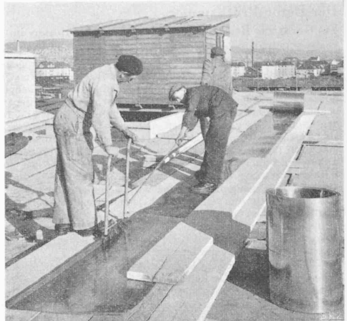
Bild 14. Ziehen des Falzes im Aluman
