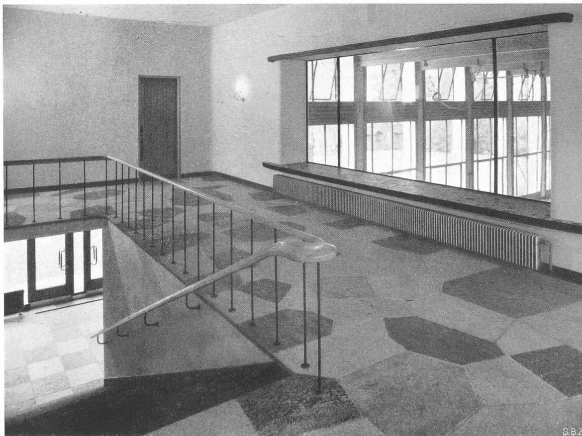
Bild 16. Vorraum Turnhalle (Gang vor Klassenzimmern)
