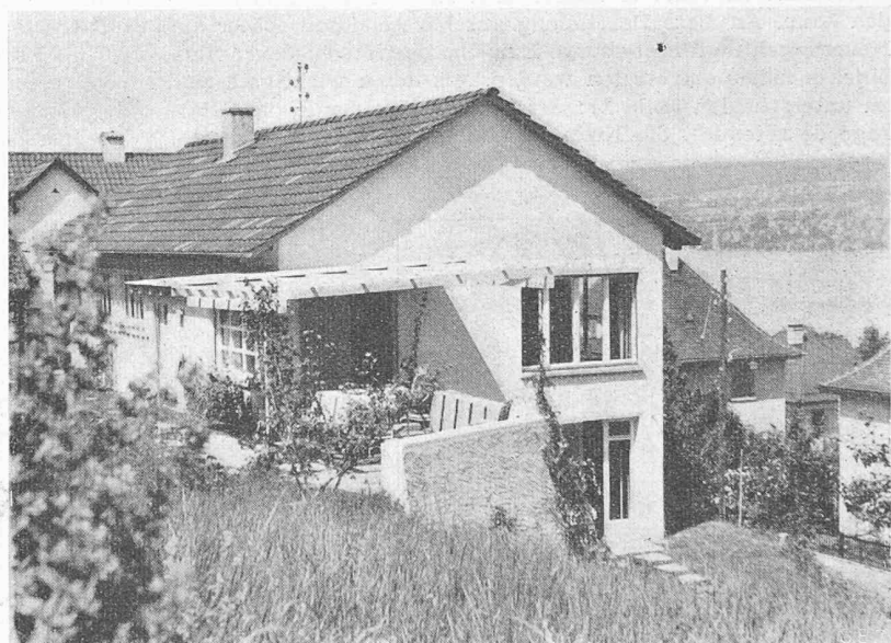
Bild 6. Ansicht von Südwesten, mit Zürichsee
