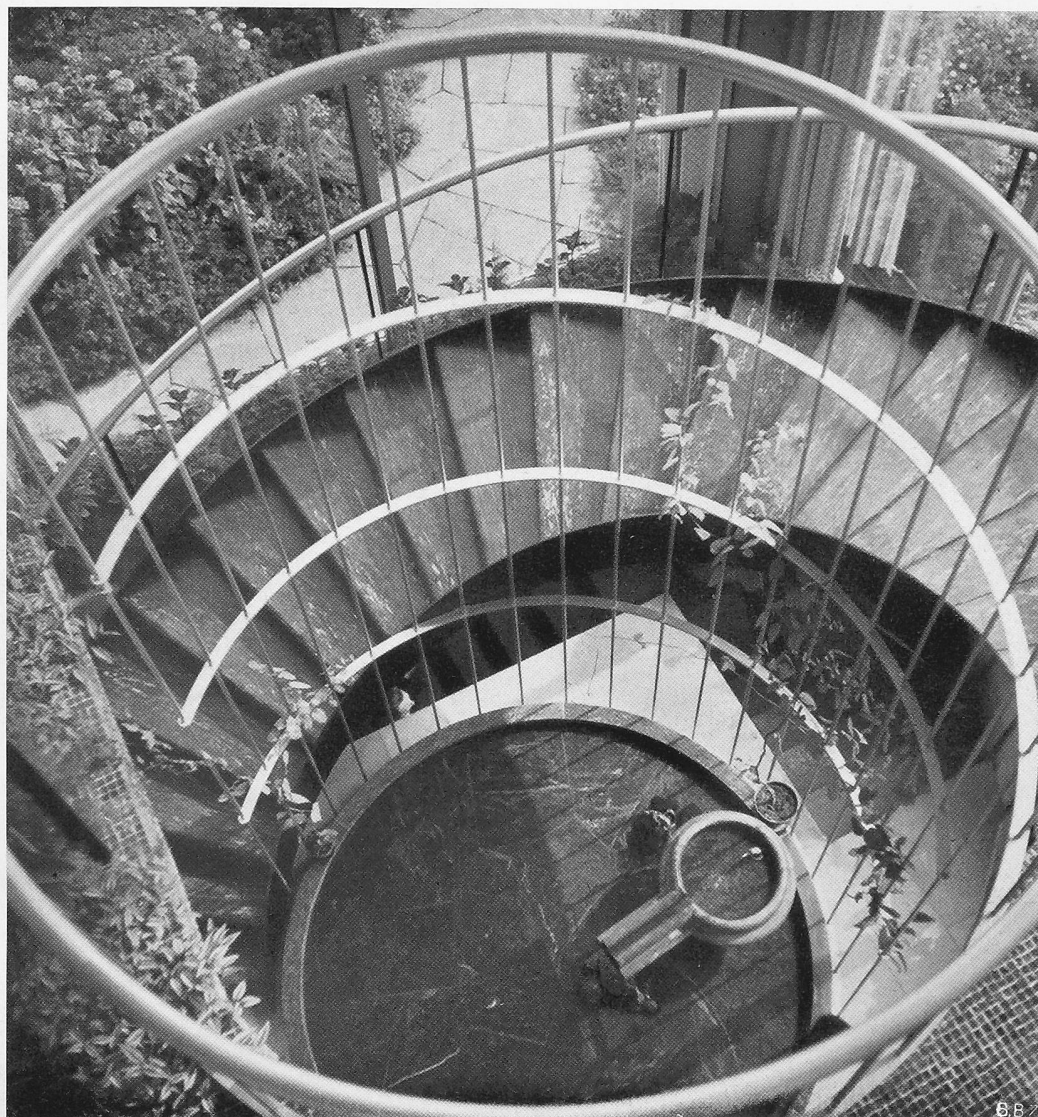
Bild 14. Blick in die Treppenanlage und auf das Zierbecken
