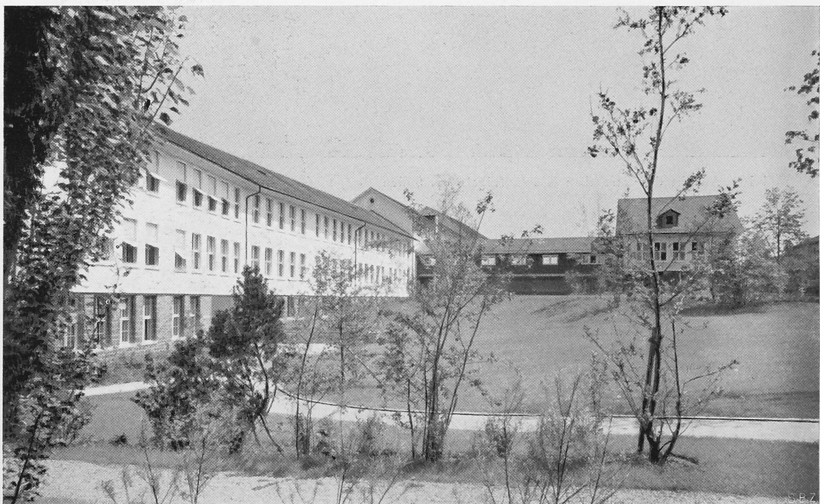
Bild 18. Westlicher Gebäudeteil mit Blick gegen die übereinander liegenden Pausenhallen
