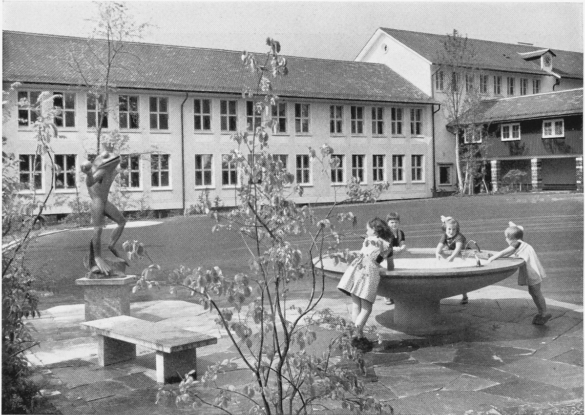
Bild 17. Pausenplatz der Unterstufe aus Süden
