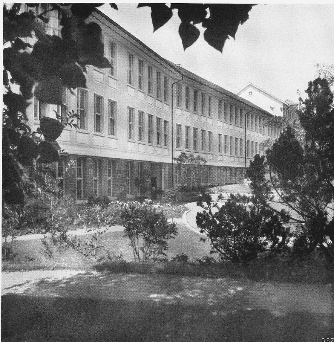
Bild 16. Ansicht des westlichen Klassenflügels aus Süden
