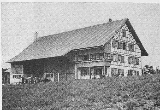
Bild 2. Dreisässenhaus bei Ossingen, Kt. Zürich. Der Riegelbau kann dank verbesserter Konstruktion vermehrt angewendet werden
