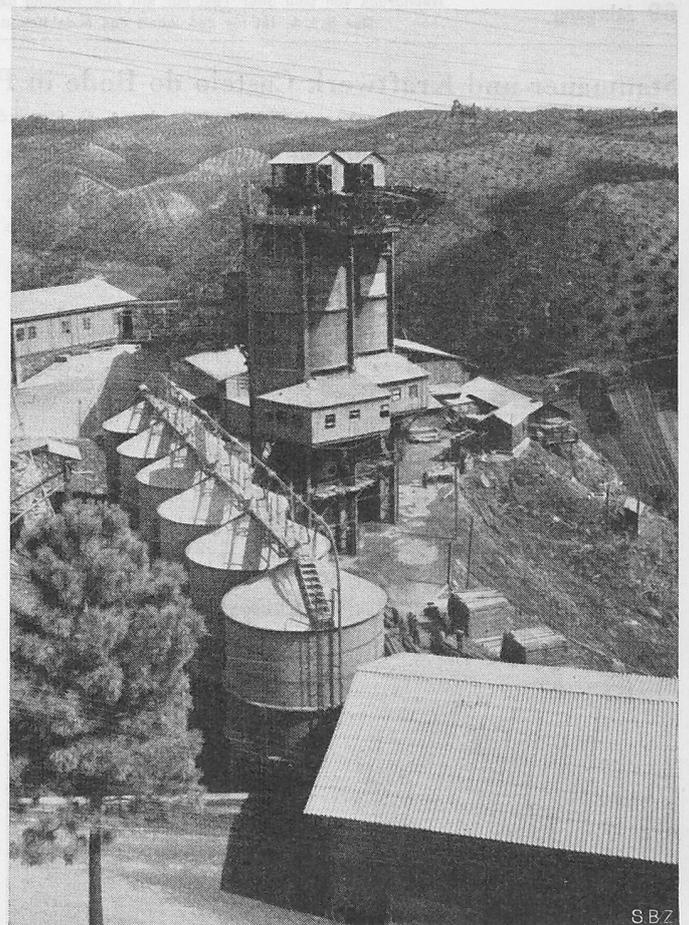
Bild 13. Zementsilos; dahinter Betoniertuerm mit Endstation der Luftseilbahn
