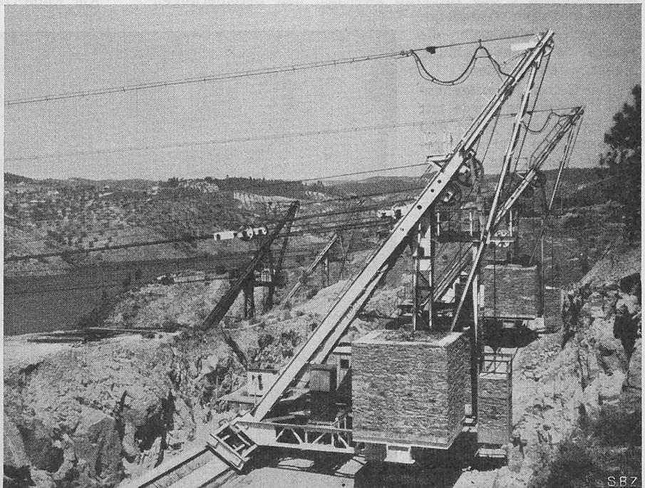
Bild 15. Die vier Fahrtürme auf zwei gestaffelten Bahnen. Fahrmotor 45 PS, ab Gegenseite gesteuert und gespeist (oberstes Kabel)
