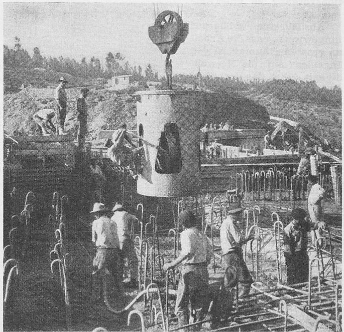
Bild 20. Betonierung der Einlauf-Decke. 3-m<sup>3</sup>-Betonkübel «Blaw-Knox» mit Verschluss aus Gummiplatte auf Stahlrollenwagen. 16. August 1950
