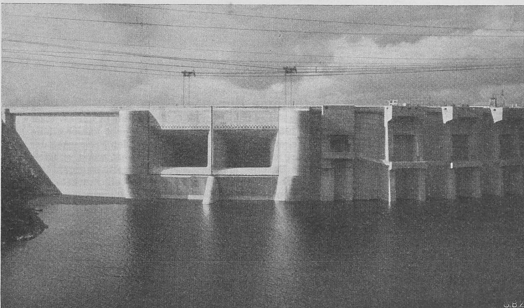
Bild 21. Einlauf zum Hochwasserüberfall, rechts Aufbauten über Grundablass und Wasserfassungen. 11. November 1950
