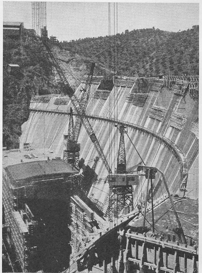
Bild 17. Betonierung Staumauer und Maschinenhaus. 3. Aug. 1949.
