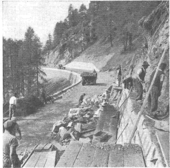
Verlegung der Julierstrasse in Marmorera
